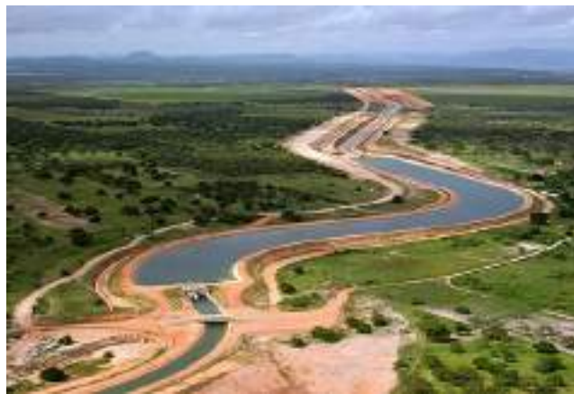
Foto 7.47: Eixo de Integração Castanhão / RMF, sistema de transposição de água entre as bacias do Jaguaribe e Metropolitana, tendo como fonte hídrica, o Açude Castanhão. Fonte: COGERH,2016.
